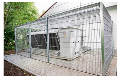
Unten links: Schematische Darstellung des Supermarkts mit der Kälteanlage Unten rechts: Die Kälteanlage auf der Rückseite des Supermarkts
