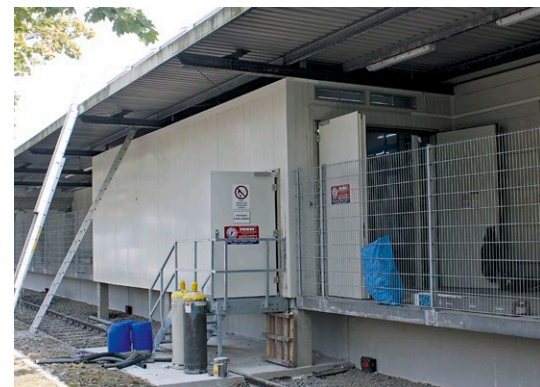
Von links nach rechts: R-723-Anlage, Schaltschrank und Eingangsbereich zu dem schallgedämmten Raum, in dem die Kälteanlage steht
