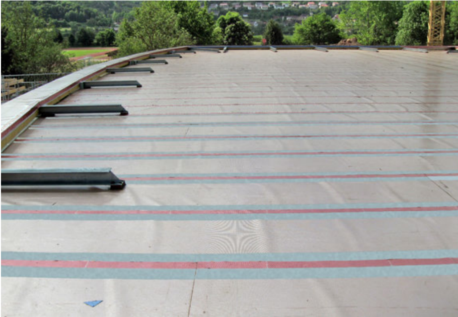
Abb. 5: Ein wesentlicher Aspekt ist die Luftdichtigkeit der Gebäudehülle: hier die Abdichtung der Dachkonstruktion
