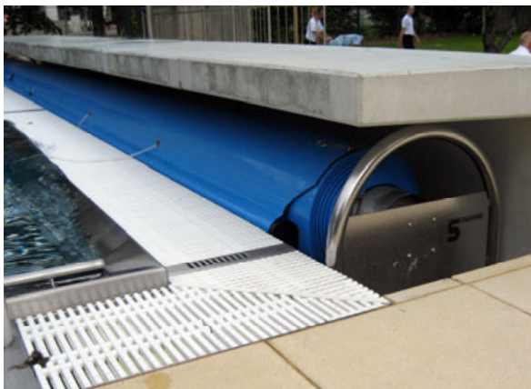
Abb. 15: Folie zum Abdecken eines Außenbeckens
