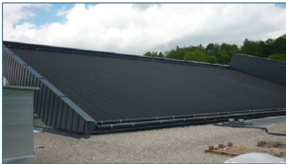
Abb. 30: Solarabsorber
