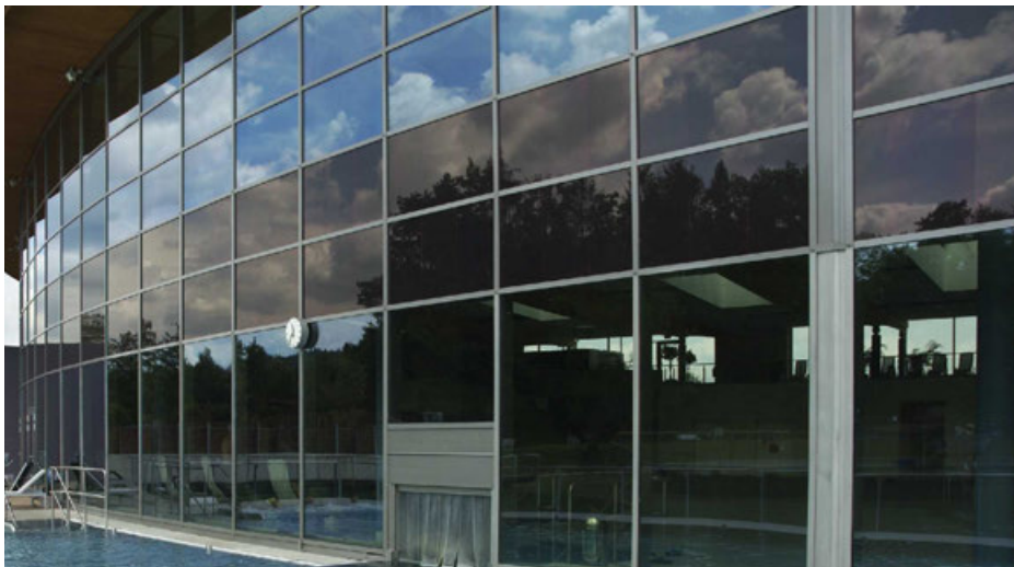
Abb. 7: Fasadengestaltung mit PV-Elementen, die gleichzeitig verschat- tend wirken.
