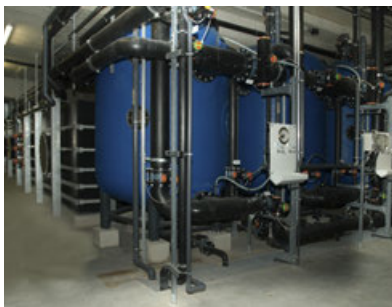
Abb. 31: Druckfilter
