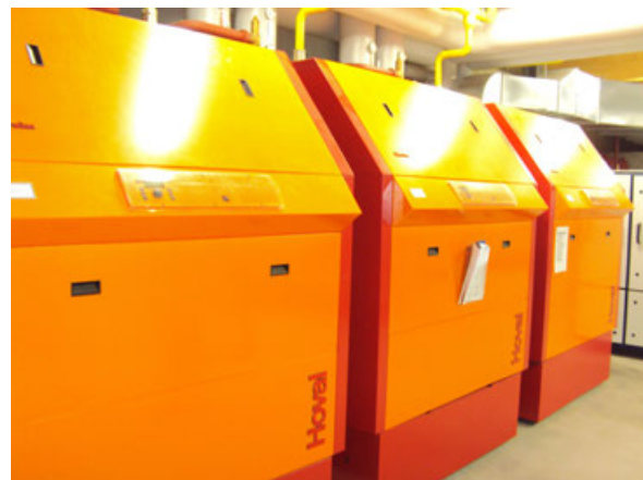
Abb. 28: Gas-Brennwertkessel
