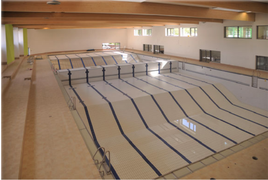
Abb. 13: Mit dem verfahrbaren Hubboden lässt sich auch das Becken in Nichtbenutzungszeiten abdecken und so die Verdunstung vermin- dern.
