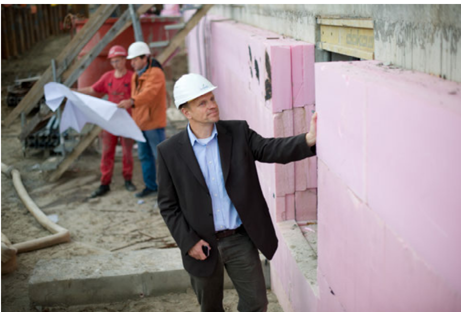
Abb. 6: Dämmung der Fassade
