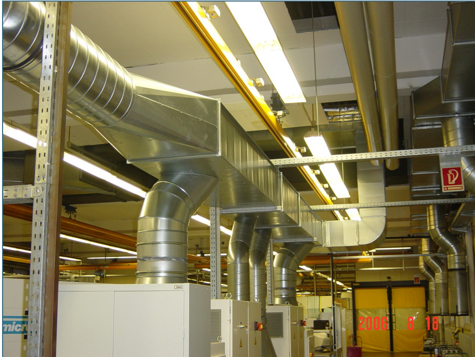
Abb. 13: Die Abwärme wird an der Wärmequelle gefasst.
