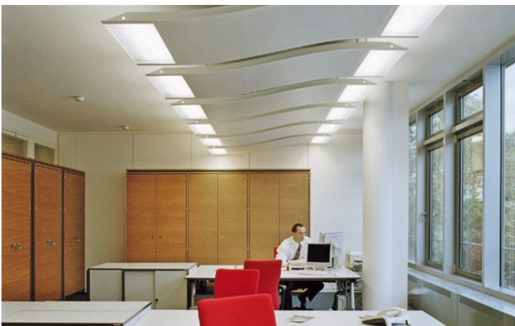
Abb. 05_02: Innenansicht eines Büroraums im Gebäude KfW-Ostarkade in Frankfurt (Projektsteckbrief: siehe Kapitel 9). Sturzfreie Fenster, eine geringe Raumtiefe, eine helle Deckenoberfläche und speziell geformte Deckensegel zur Lichtumlenkung tragen zu einer sehr guten Tageslichtausleuchtung des gesamten Raumes bei. [Quelle: Architekten RKW Rhode Kellermann Wawrowsky]
