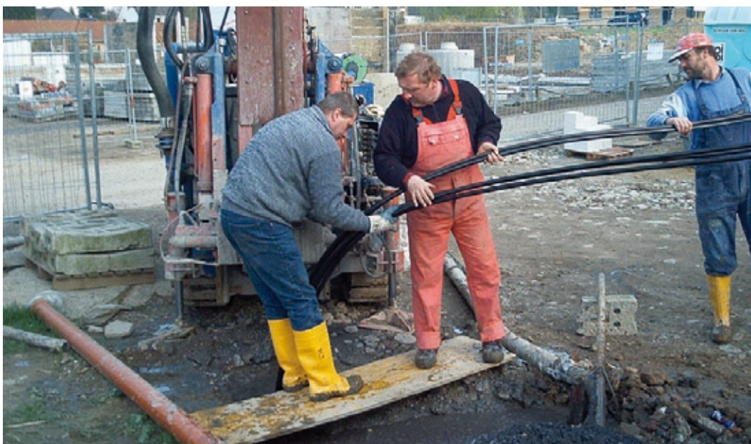
Abb. 06_01: Einbringen einer Erdsonde in das Bohrloch beim Neubau des Bürogebäudes BOB in Aachen. Die Erdsonden reichen bis in eine Tiefe von 45 m und sorgen in Verbindung mit einer Wärmepumpe und einer Betonkernaktivierung in den Geschossdecken für die Wärme- und Kältebereitstellung. [Quelle: VIKA Ingenieure]
