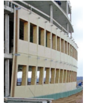
Abb. 02_02: Fassade des Bürogebäudes Energon in Ulm (Projektsteckbrief: siehe Kapitel 9) während der Bauphase: die komplett vorgefertigten Holz-Fassadenelemente in Passivhaus-Standard werden an die Geschossplatten gehängt. Pro Geschoss gibt es einen Elementtyp. [Quelle: Architekt Stefan Oehler]
