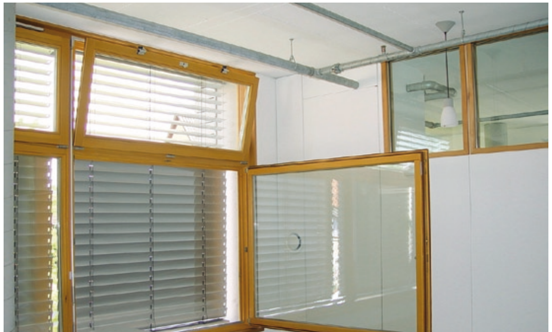
Abb. 04_04: Innenansicht des Sonnenschutzes im Bürogebäude Lamparter in Weilheim. Die horizontale Lamellenstellung im Oberlichtbereich sorgt durch Lichtumlenkung für eine ausreichende Tageslichtversorgung bei gleichzeitigem Sonnen- und Blendschutz. [Quelle: EnBau: MONITOR]
