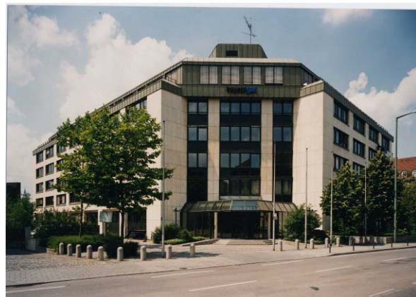
Abbildung 3.7: Verwaltungsgebäude der Bayerngas GmbH in München (oben) und Mikrogasturbine im Heizungskeller (links)
