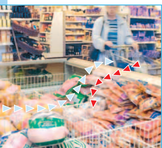
Überschreiten der Stapelhöhe leitet die Kaltluft aus der Truhe.
