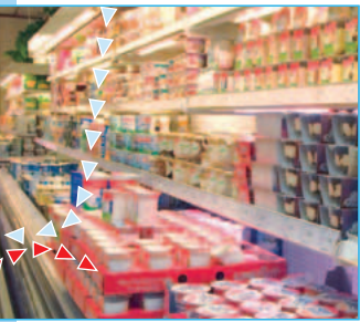
Falsche Stapelung lenkt den Kälteschleier aus dem Regal.
