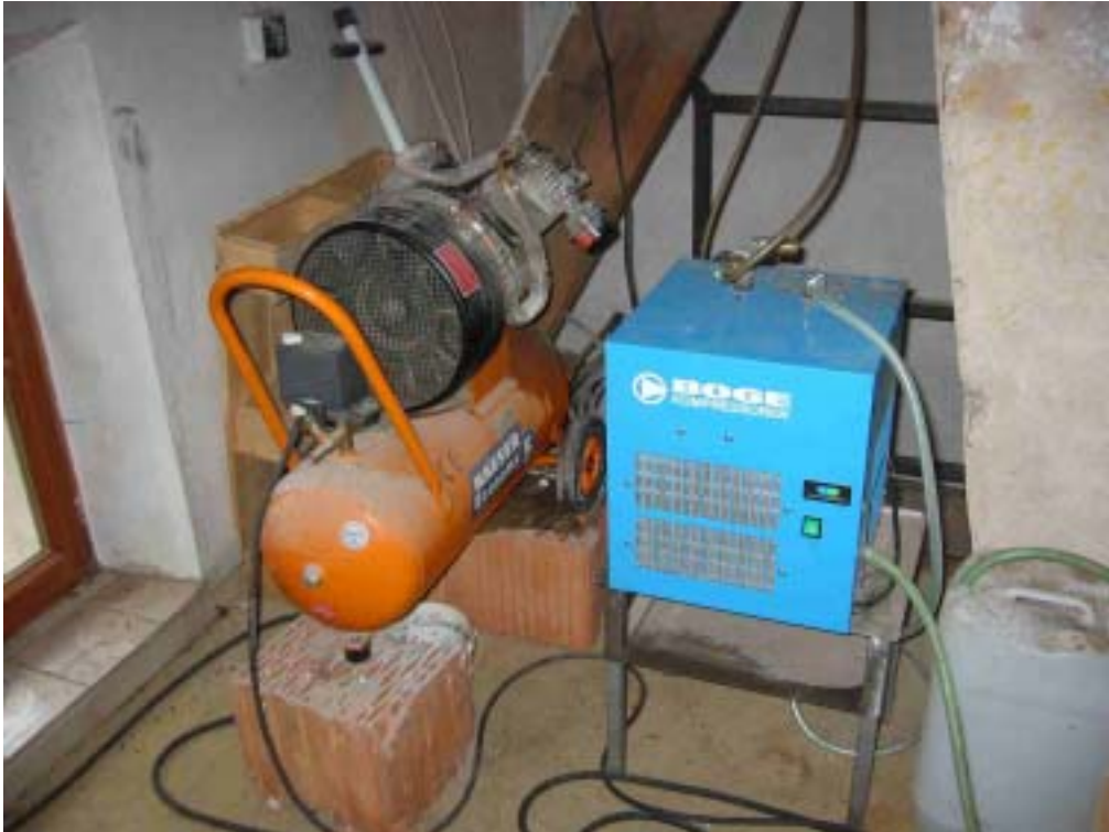
Abb. 19: verschmutzter Kolbenkompressor
