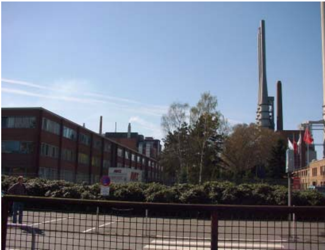
Abb. 3: Standort Obernburg; Ausschnitt. Im Hintergrund links das Produktionsgebäude, rechts das Kraftwerk
