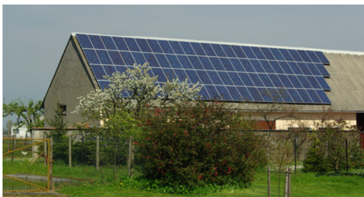
Abb. 11: Auf Asbestdächern dürfen keine Photovoltaik- oder Solaranlagen montiert werden!
