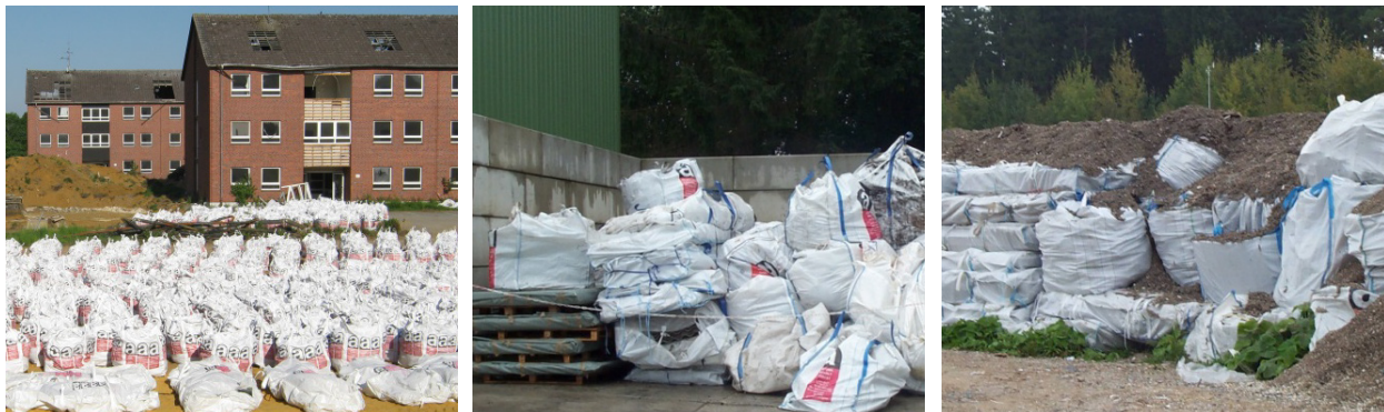
Abb. 17: Asbesthaltige Abfälle werden auf der Baustelle in Big-Bags verpackt (links) und in einer Sammelstelle abgegeben (Mitte). Auf der Deponie werden die Big-Bags abgedeckt, um eine Beschädigung und eine Freisetzung von Fasern zu verhindern (rechts, noch unvollständig abgedeckt).
