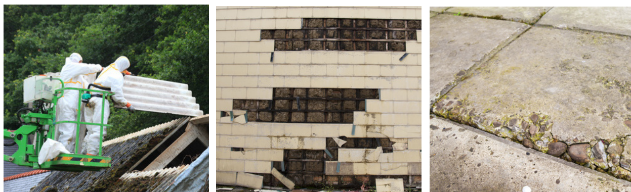
Abb. 14: Beschädigte Dachplatten sollten bald ausgetauscht werden, ebenso kaputte Fassadenschindeln und defekte Bodenplatten.
