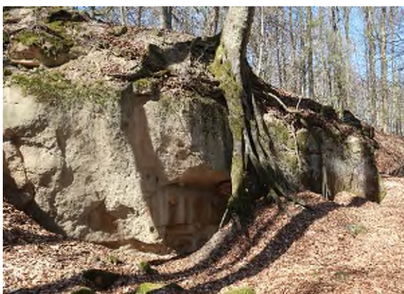
Abb. 20: Gespannte Wurzeln am Anbruchbereich einer Rutschung im Oberen Keuper. Die Gleitfläche reicht vermutlich bis in den Feuerletten.
