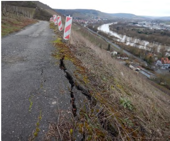
Abb. 18: Schäden am Weg in einem Weinberg im Oberen Muschelkalk im Landkreis Würzburg
