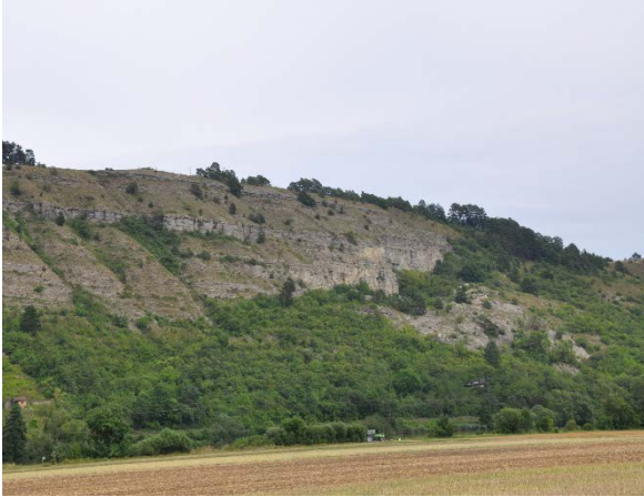
Abb. 4: Rutschung am Kalbenstein
