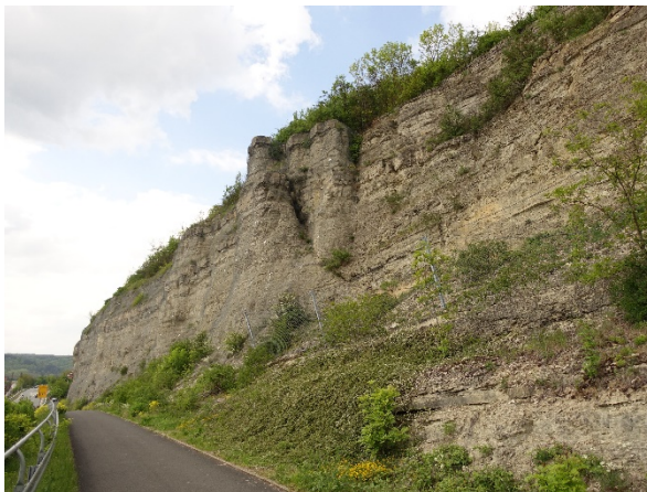
Abb. 2: Vor Steinschlaggefährdung gesicherte Straße südlich von Bad Retzbach
