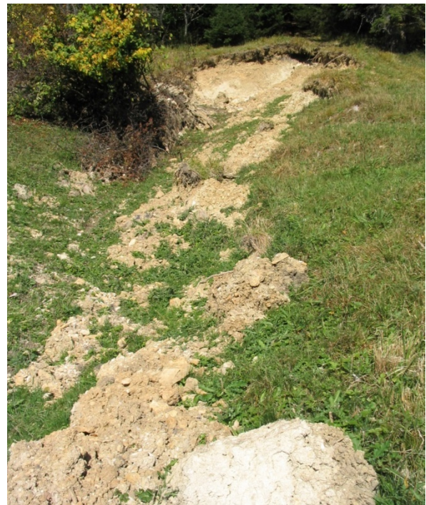
Abb. 4: Hanganbruch oberhalb „Reiche Wiesen“ in Unterammergau
