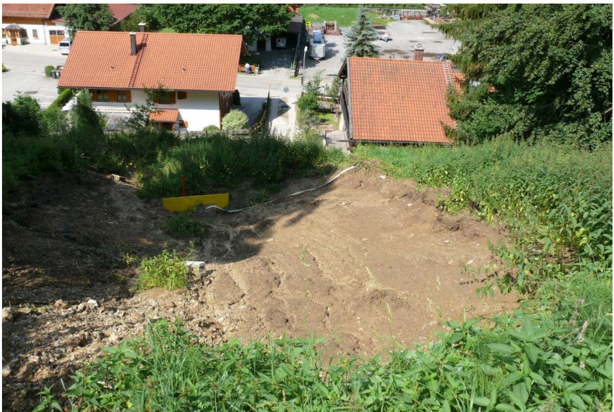
Abb. 4: Ablagerungsbereich eines Hanganbruchs nördlich Brandlberg in Ruhpolding
