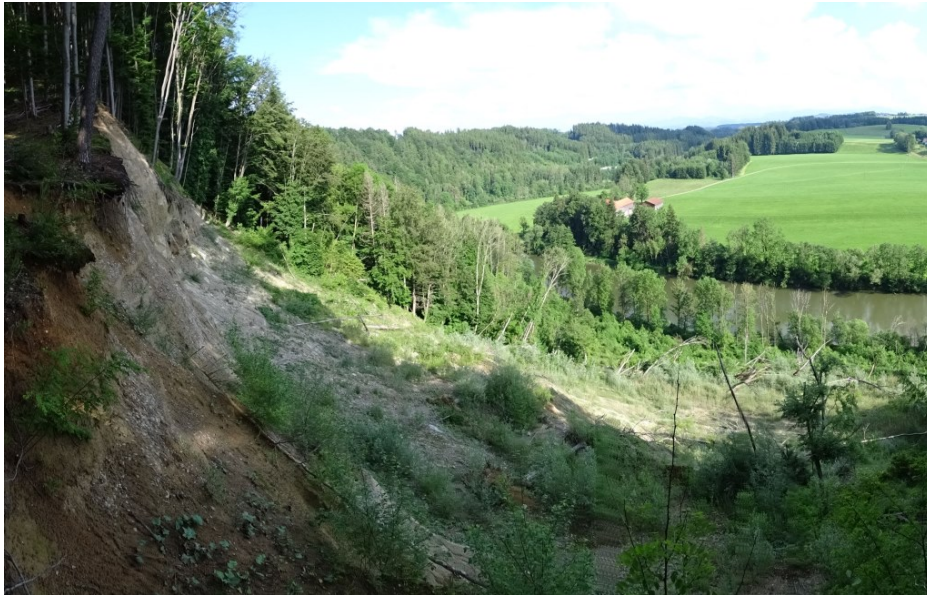
Abb. 24: Anbruchbereich einer Rutschung an der Iller südwestlich von Sach- senried, nördlich von Altusried
