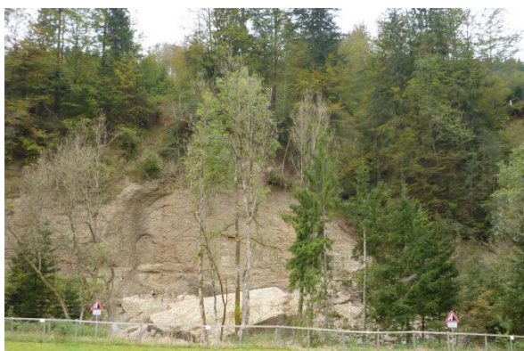
Abb. 3: Felssturz im Eschachtal
