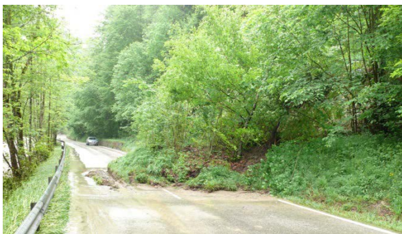
Abb. 5: Rutschung südwestlich von Wartbichl
