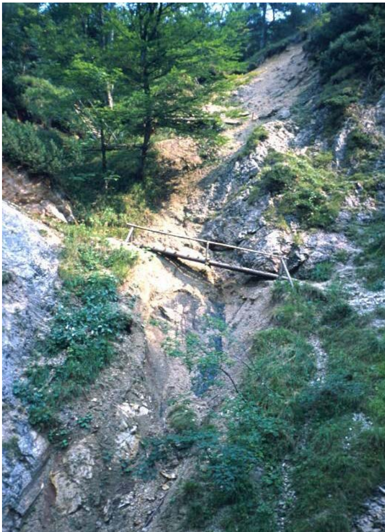
Abb. 5: Rutschung am Rackelboden südlich von Bayerisch Gmain
