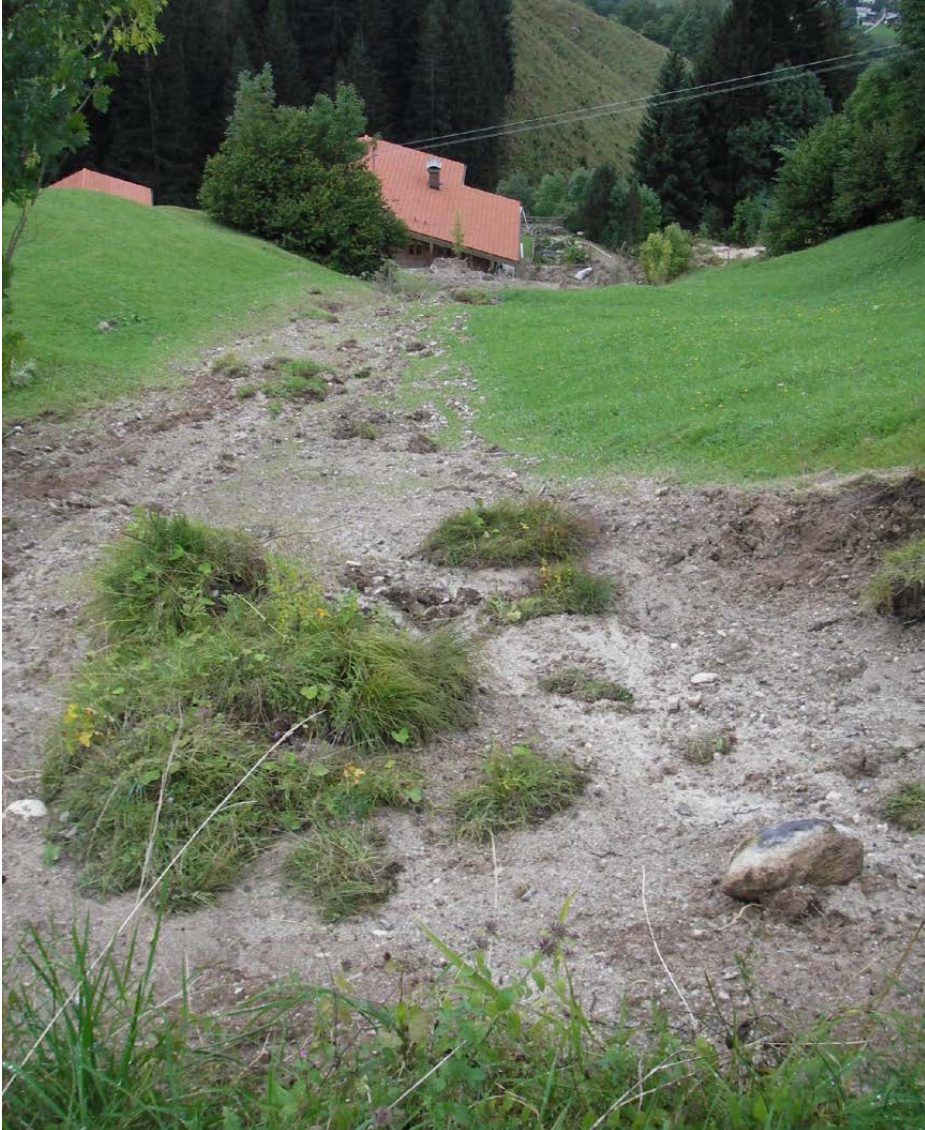
Abb. 3: Hanganbruch bei Unterhäusl in Ramsau bei Berchtesgaden
