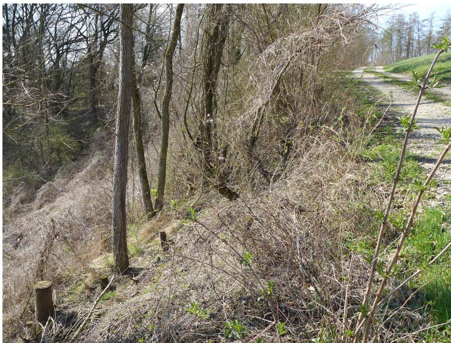
Abb. 12: Rutschung südwestlich von Riedensheim. Blick über die Anbruchkante mit dem dahinter ver- laufenden Wirtschafts- weg und auf die Rutschmasse
