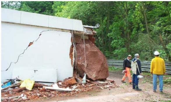
Abb. 2: Kleiner Felssturz (etwa  $200 \text{ m}^3$ ) in einem ehemaligen Steinbruch westlich von Miltenberg
