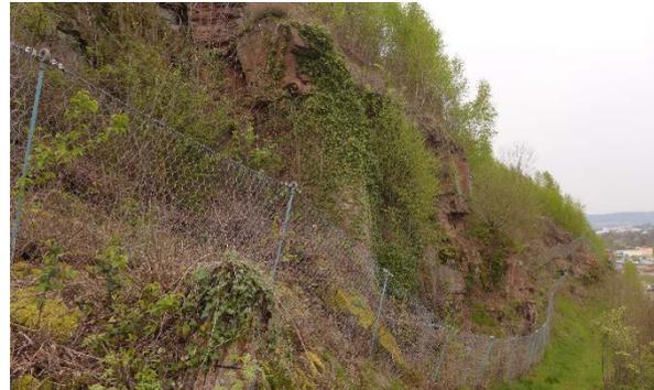
Abb. 3: Felsicherung mit Hilfe eines Schutzzauns nahe des ehemaligen Steinbruchs westlich von Miltenberg (s. Abb. 2)
