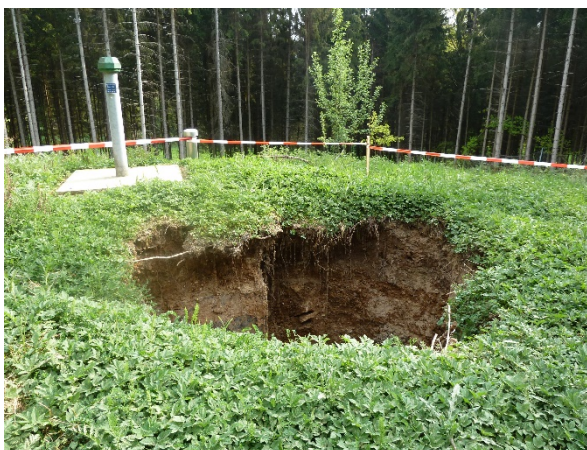
Abb. 6: Erdfall südöstlich von Hub. Die Tiefe beträgt maximal 3 m.
