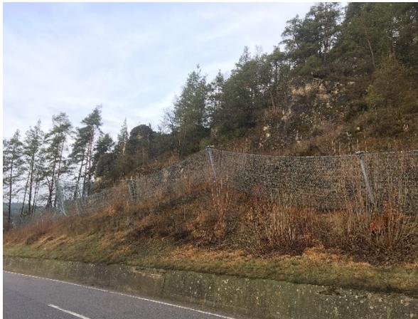
Abb. 2: Vor Steinschlaggefährdung gesicherter Hangbereich entlang der St 2235 im Lauterachtal
