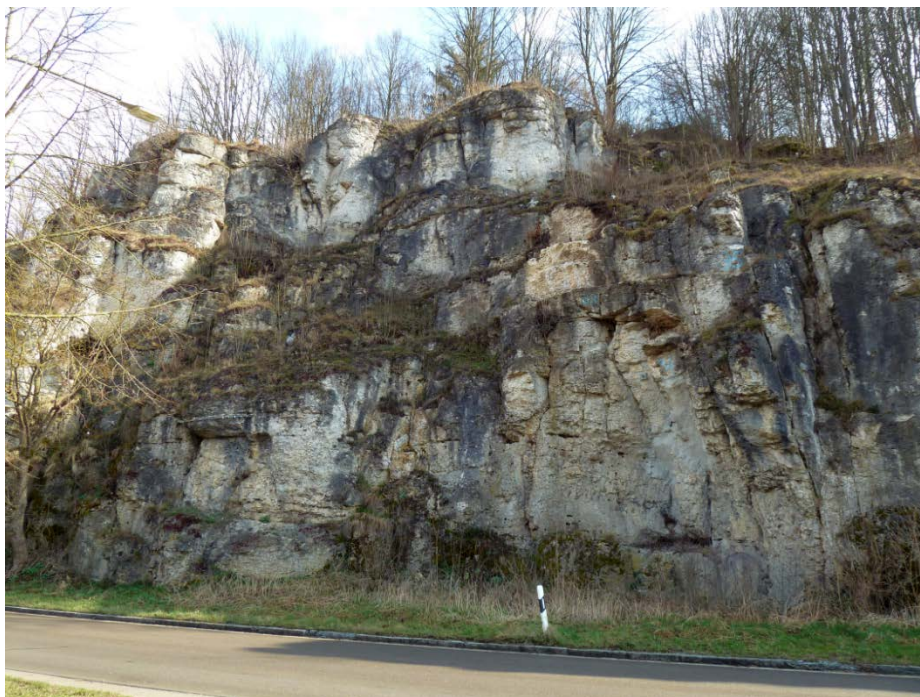
Abb. 12: Freistehende Riffkomplexe aus Dolomit bilden die typischen Felsformationen an den Talflanken. Neben kleinstückiger Verwitterung (u.a. unten rechts) sind stellenweise große Kluffkörper zu erkennen (u.a. oben links).
