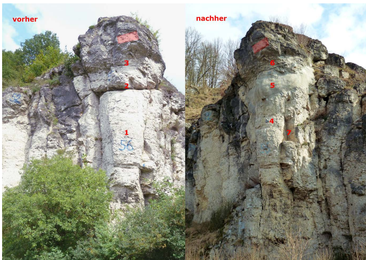
Abb. 13: Riffkomplex bei Beratzhausen vor und nach Felssicherungsmaßnahmen. Links: Kleinstückig verwitternder Felsbereich (1) unterhalb eines an einer Trennfläche (2) abgelösten Blockes mit ca. 4 m Kantenlänge (3). Rechts: Zur Sicherung des Blocks wurden einerseits Felsnägel installiert (4), um die Auflagefläche für den Block zu bewahren. Des Weiteren wurde der Block an der Trennfläche mit Beton unterfüttert (5) und durch Drahtseile zusätzlich gesichert (6). Im unteren Bereich wurden lockere Blöcke abgetragen (7) (rote Fläche zur Orientierung).
