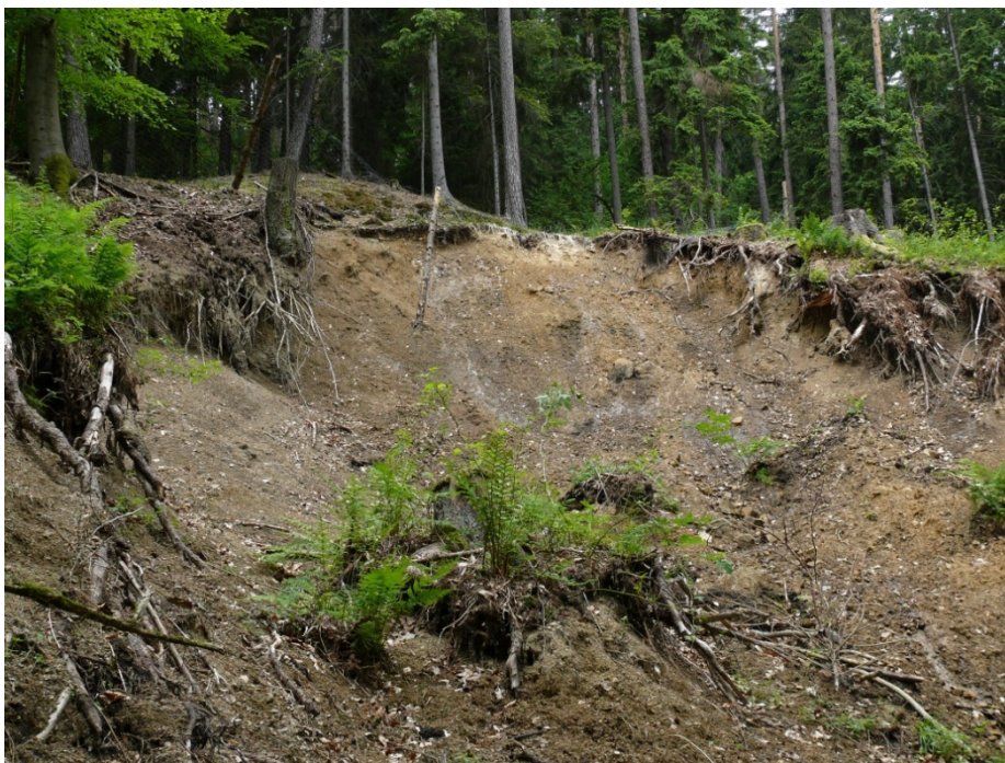
Abb. 3: Anbruchbereich einer Rutschung an der Hall- leite westlich von Wüs- tendorf
