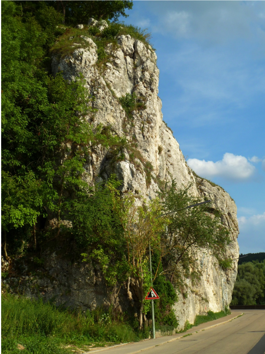
Abb. 9: Riffkomplex bei Wel- tenburg mit Stein- schlagsicherungen: Netze, Felsanker, Spritzbeton.
