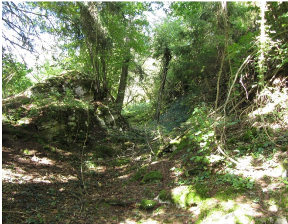
Abb. 3: Rutschung östlich Biberbach. Rechts im Bild: versteilter Hang des Abrisses, links: talsauswärts gekippte Malmkalkscholle. Dazwischen eine sogenannte „Zerrspalte“.
