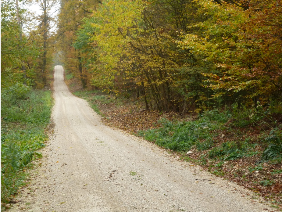
Abb. 12: Absenkungen an einem Forstweg in der Nähe einer großen Doline südwestlich Pfahldorf. Das im Untergrund existierende Hohlräumssystem kann sich auch in der Nähe von bekannten, großen Einsturzbereichen durch Absenkungen im Gelände äußern, welche potenziell Schäden verursachen können (bei asphaltierten Straßen z. B. Risse in der Asphaltdecke).
