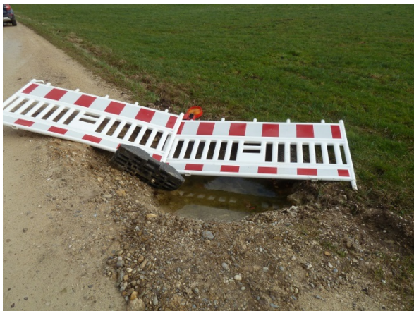
Abb. 5: Verfüllter Erdfall mit Nachbruch an einem Feldweg zwischen Mühlheim und Ensfeld (Ensfelder Tal).
