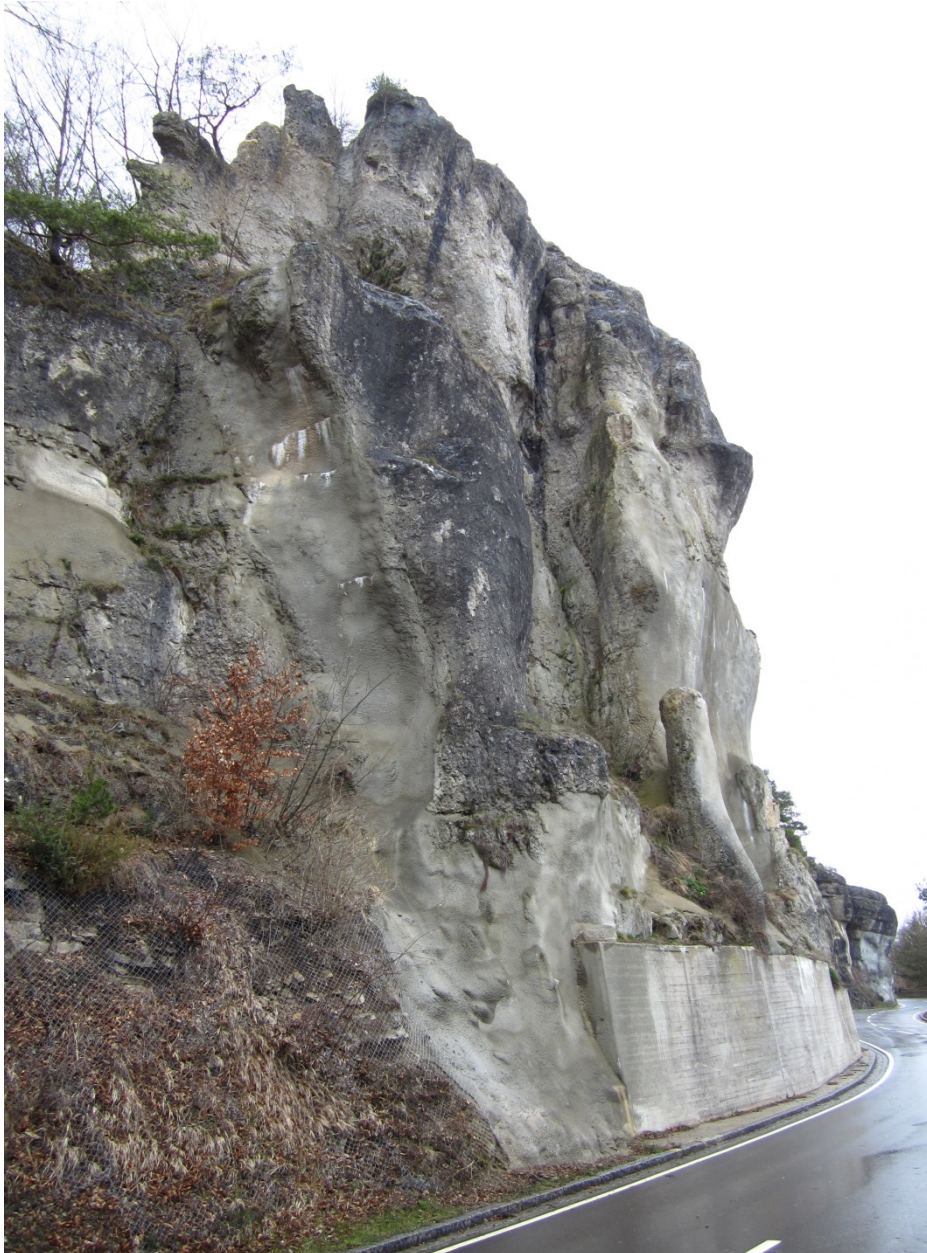
Abb. 9: Sanierter Felsbereich oberhalb Kinding. Durch die Unterfütte- rung mit Spritzbeton und eine Unterfangung durch eine Stützmauer wurde der stellenweise überhängende Riff- komplex stabilisiert.
