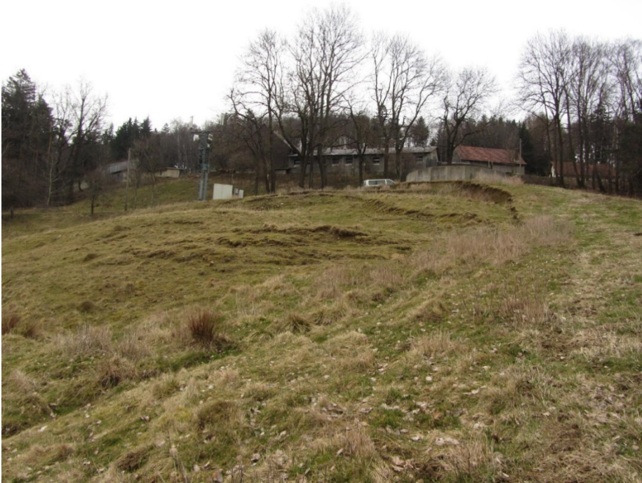
Abb. 4: Rutschung bei Culm- berg
