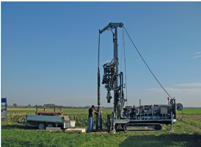
Abb. 1: Bohrung GFK 5 südöstlich von Prittriching, 07.10.2009
