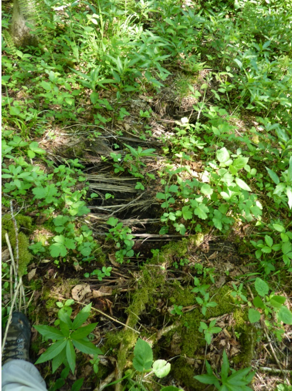
Abb. 13: Risse im Boden mit gespannten Wurzeln können erste Anzeichen für Rutschungsbewegungen sein.
