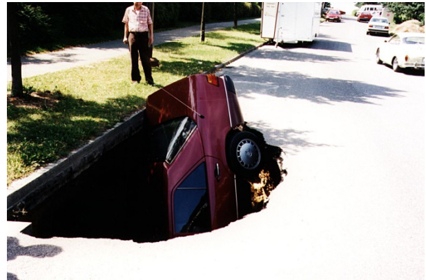
Abb. 29: Ein Erdfall in Regensburg verursachte im Jahr 1994 Sachschaden. GEORISK Nr. 6938GR015002
