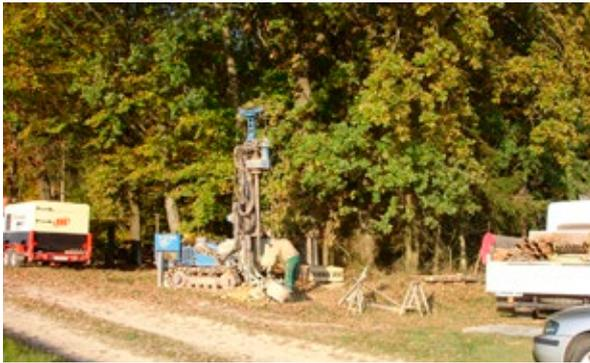
Abb. 6-2: Abteufen der Bohrung Q 12 zur Quarzkies-Erkundung
