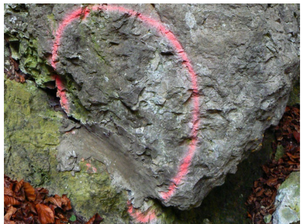
Abb. 4: Für Felssiegel hat sich z. B. Schnellbinderzement gemischt mit 50% Sand bewährt. Bei größeren Spalten kann beidseitig ein kurzes Baueisen o. Ä. in einem Bohrloch die Verbindung mit der Felsoberfläche verbessern. Gegebenenfalls kann eine provisorische „Schalung“ notwendig sein. Einfache Felssiegel können in Eigenregie erstellt und kontrolliert oder bei einer Fachfirma in Auftrag gegeben werden.
