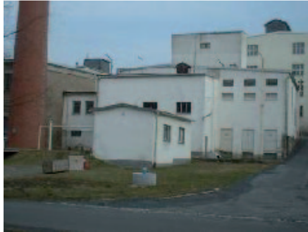
Abb. 20: Kesselhaus und zugehörige Nebenbetriebe. vorne links Basis des Rauchgasschornsteins; Bildmitte (klein): Brauchwasseraufbereitung, dahinter Kesselhaus mit siloartigem Überbau des eigenen Kohlebunkers.
