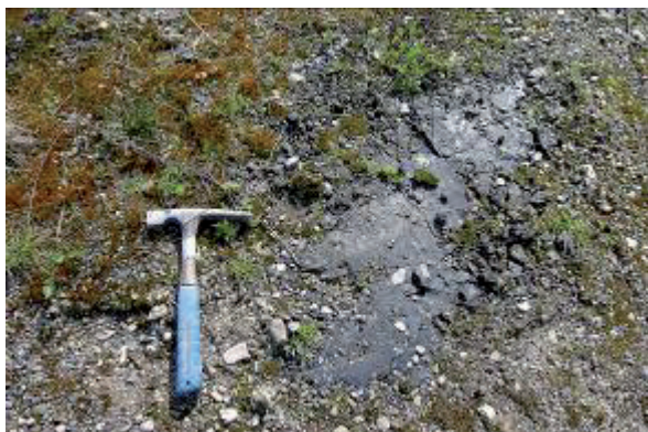
Abb. 38: An der Oberfläche eines Ablagerungsbereiches austretende Teerkondensate.
