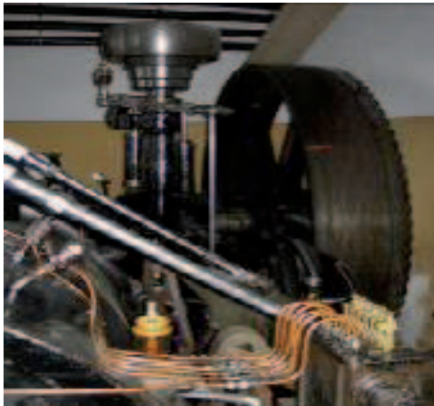
Abb. 19: Dampfmaschine im Kesselhaus einer Porzellanfabrik. Erkennbar sind die Schmierölbuchsen und Öldruckleitungen als Kontaminationsquellen.
