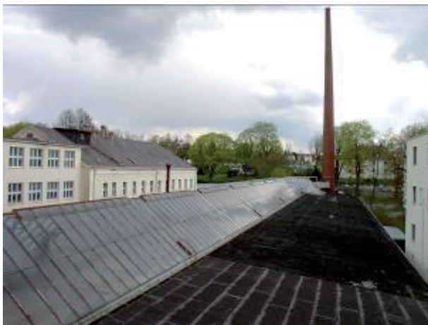
Abb. 13: aufgelassene Tunnelofenhalle mit Oberlichtern und Abluftschorstein der Öfen.
