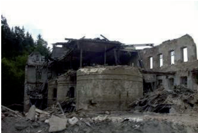
Abb. 22: Rundofenbatterie beim Rückbau einer Porzellanfabrik. Das oberste Ofenstockwerk und die Abluftschornsteine waren bereits während des Betriebs entfernt und überbaut worden.
