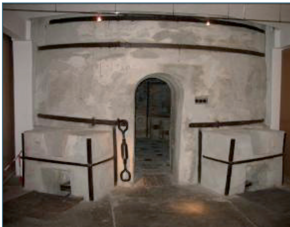
Abb. 10: Rundofen. Beiderseits der Eintragsöffnung zwei Feuerungskästen. Eisenkorsettierung des Ofenmauerwerks mit einhängbarer Spannschraube vor der Öffnung. Im Boden des Brennraums liegen die Abzugsöffnungen für die Führung Brenngase in „überschlagende Flamme“ (dunkle Flecken), welche über Füchse im Mauerwerk zu den darüber liegenden Kammern geführt werden.
