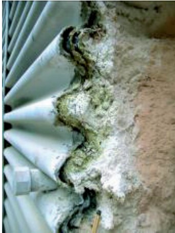
Abb. 29: Hochtemperaturzone eines Tunnelofens (Glattofen). Querschnitt durch den äußeren Teil der Ofenwand mit Stahlblechkorsettierung (links) und altrosa bis ockerfarbener Kieselgur-Isolierung (rechts). Mit Erreichen der Kondensationstemperatur sind aus der Brennzone diffundierte Schadstoffe (Sulfat, Metalloxide) dicht unter der Korsettierung als weiße und gelbe Schicht ausgefallen und korrodieren die Ofenverblechung.
