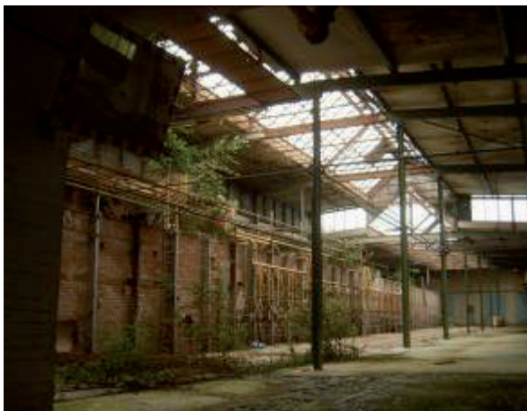
Abb. 11: Stillgelegte Ofenhalle und Tunnelofen mit Hochtemperatur- bzw. Brennzone.
