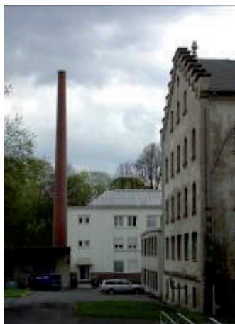
Abb. 18: Ehemaliges Gasgeneratorenhaus Erkennbar sind das große Oberlicht, der Rauchgasschornstein sowie ein Teil des ehem. Kohlelagers (links).
