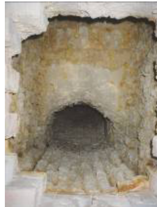
Abb. 15: Rauchzug mit schwarzen Inkrustationen am Mauerwerk und Staubablagerungen (Bild links); stark inkrustierter Rauchzug (rechtes Bild)
