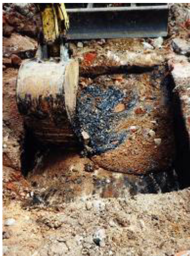
Abb. 16: Tiefgründig mit PAK und Phenolen (schwarz) imprägnierter Boden im Bereich der Befuerung mit Rauchzügen
