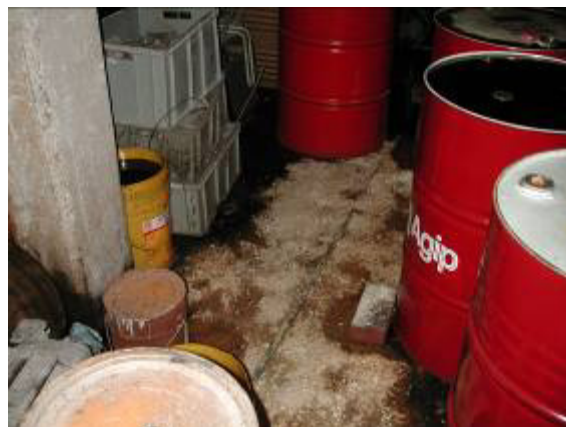
Abb. 19: Unsachgemäße Lagerung von Kraft- und Schmierstoffen, Ölen, etc.
