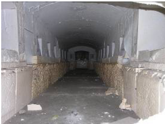
Abb. 3: Innenansicht Wannenofen mit querziehender Flamme
