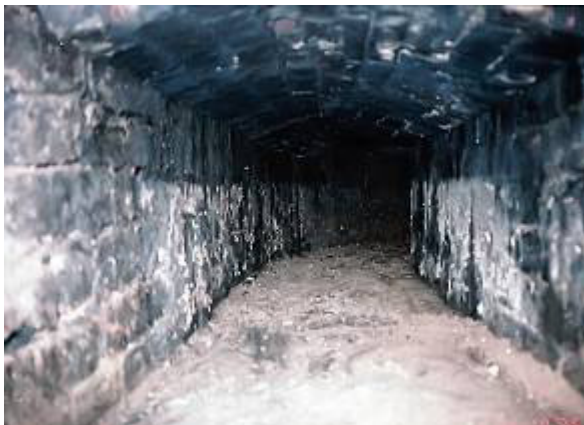
Abb. 15: Rauchzug mit schwarzen Inkrustationen am Mauerwerk und Staubablagerungen (Bild links); stark inkrustierter Rauchzug (rechtes Bild)
