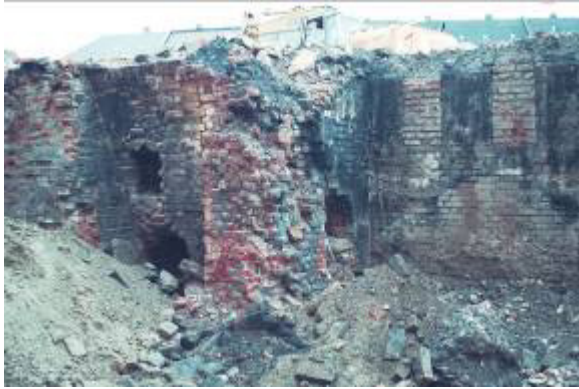
Abb. 16: Tiefgründig mit PAK und Phenolen (schwarz) imprägnierter Boden im Bereich der Befuerung mit Rauchzügen
