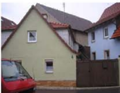
Straßenansicht Haus Nr. 4 (Süd)
