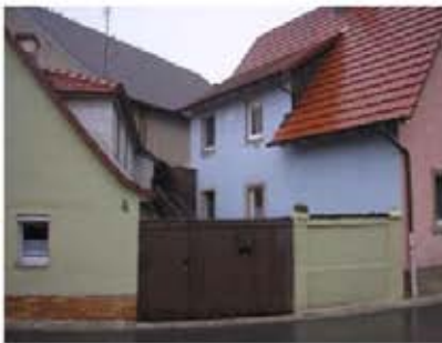
Straßenansicht Haus Nr. 2 (West)
