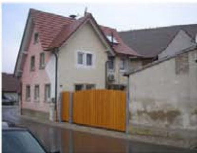
Straßenansicht Haus Nr. 2 (Ost)
