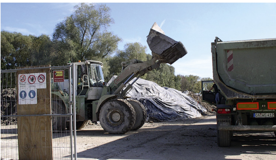
Bodenaushub auf dem ehemaligen Holzimprägnierwerk Senden
