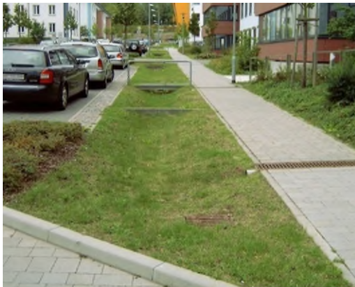
Abb. 10: Funktional – herkömmliche Versickerungsmulde mit Rasenbegrünung
