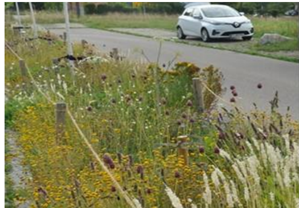
Abb. 11: Zukunftsorientiert und praxistauglich - multifunktionale Versickerungsmulde mit artenreicher Bepflanzung (Pilotstandort)
