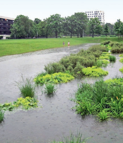
oben links: Versickerungsmulden nehmen überschüssiges Regenwasser auf und entlasten bei → Starkregen die Kanalisation.
