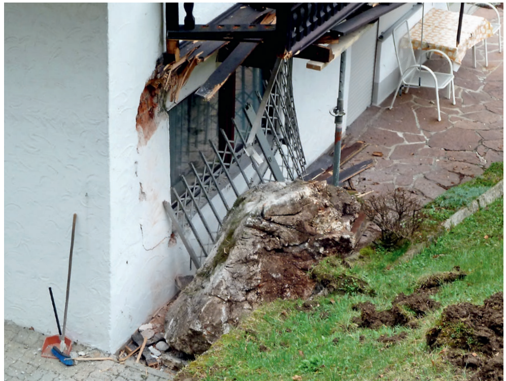
Auch kleine Felsstürze können zu hohen finanziellen Schäden führen. Im Zweifelsfall raten Experten von Neubauten im Gefahrenbereich ab.
