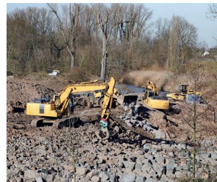
Baggerarbeiten während der Renaturierung eines Fließgewässers.
