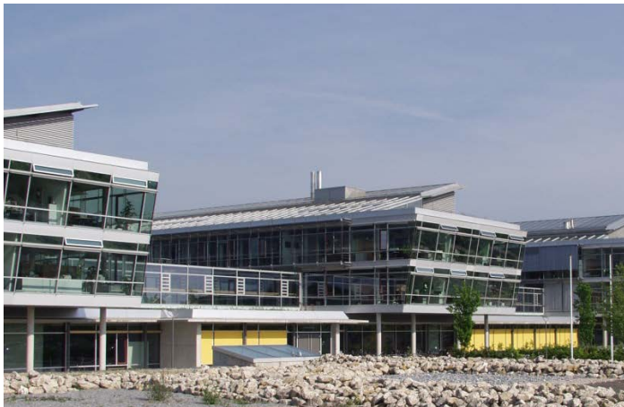
Abb. 1: Standort Augsburg Bürgermeister-Ulrich Str. 160 86179 Augsburg
