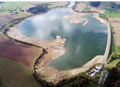
Luftbild der Förmitzdalsperre vom 25. September 2018
