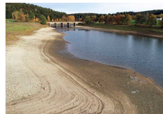
Der stark beanspruchte Liebensteinspeicher bei Tirschenreut: 70 % des Betriebsraumes wurde zur Niedrigwasseraufhöhung der Tirschenreuther Waldnaab genutzt.
