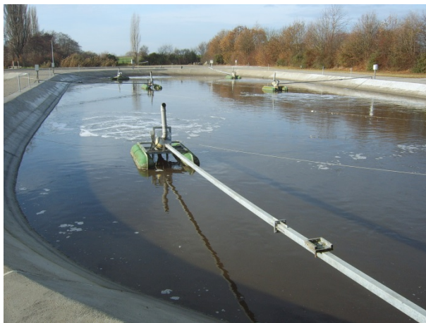
Abb. 7: Beispiel einer Abwasserteichanlage mit technischer Zwischenstufe
