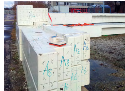
Freigemessene Betonstrukturen im Kernkraftwerk Isar 1
