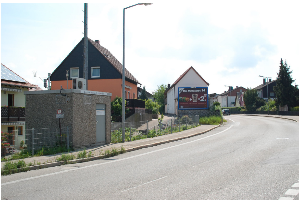
Abb. 42: Lage der Messstation Kelheim/Regensburger Straße (KERE) – Blick nach Osten.
