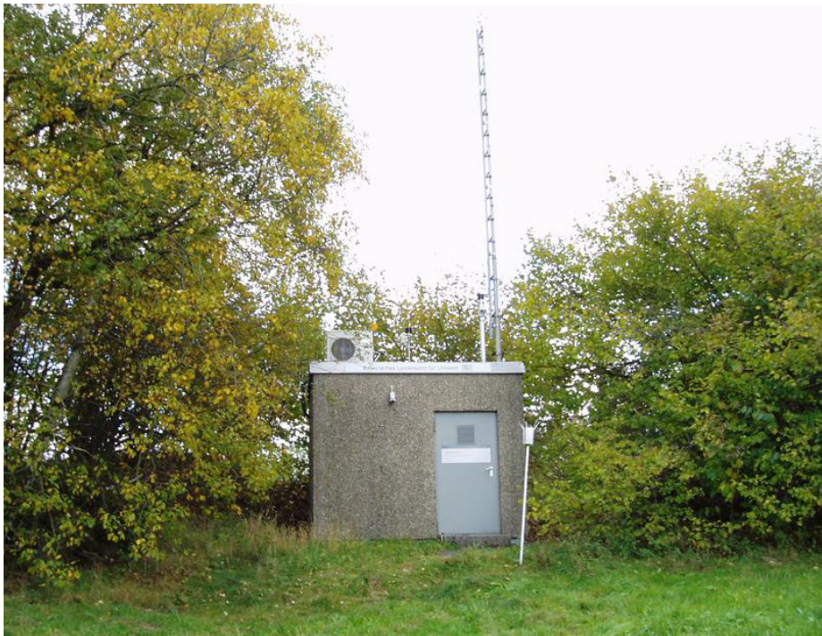
Abb. 33: LÜB-Messstation Tiefenbach/Altenschneeberg (TBAL), Stationsansicht Blick- richtung Ost.
