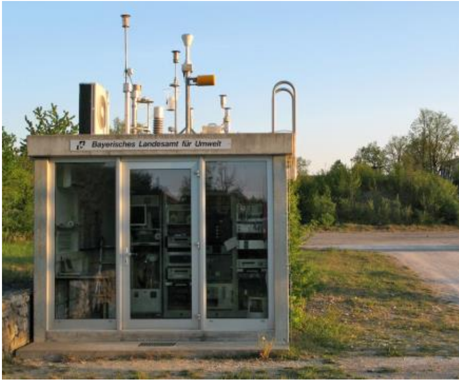
Abb. 9: Stationsansicht Blickrichtung Süd
