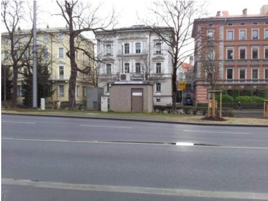
Abb. 7: Stationsansicht Blickrichtung Nord-Ost
