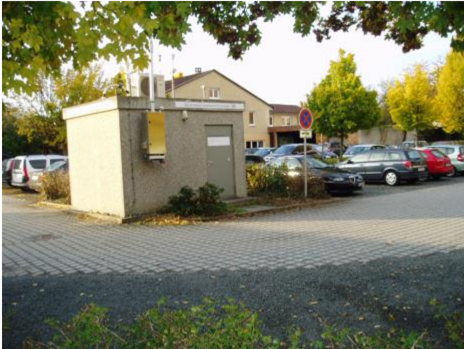
Abb. 15: Stationsansicht Blickrichtung Süd
