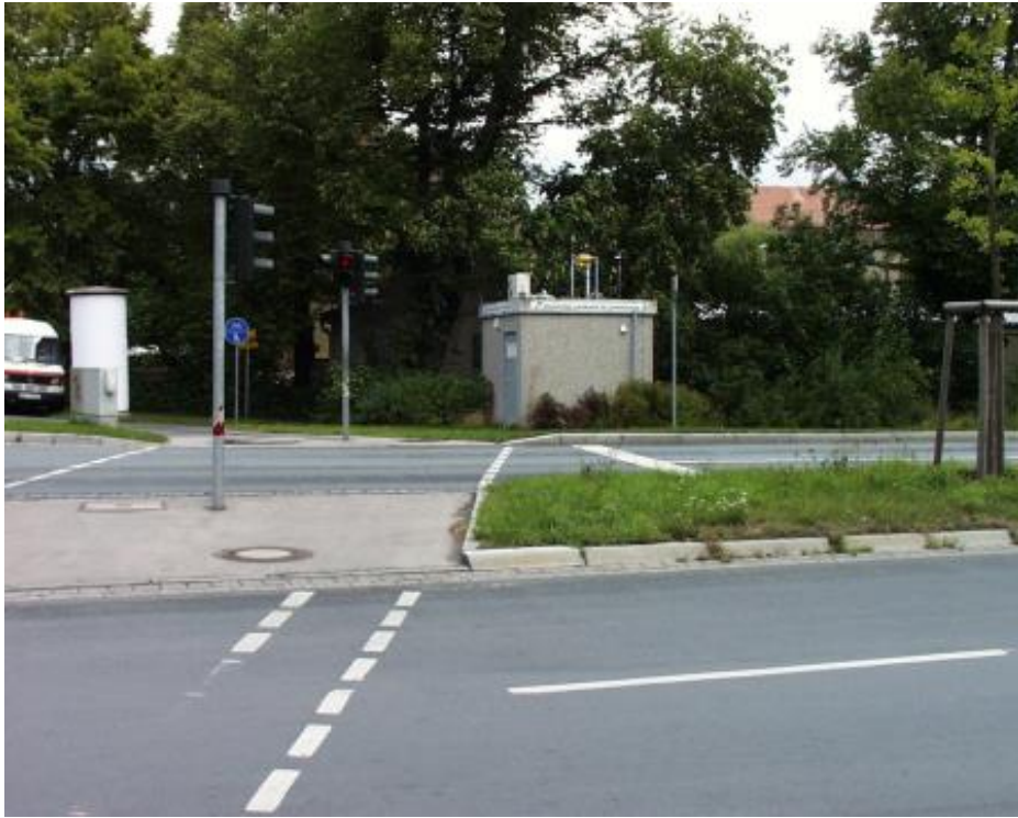
Abb. 3: Stationsansicht Blickrichtung Nord
