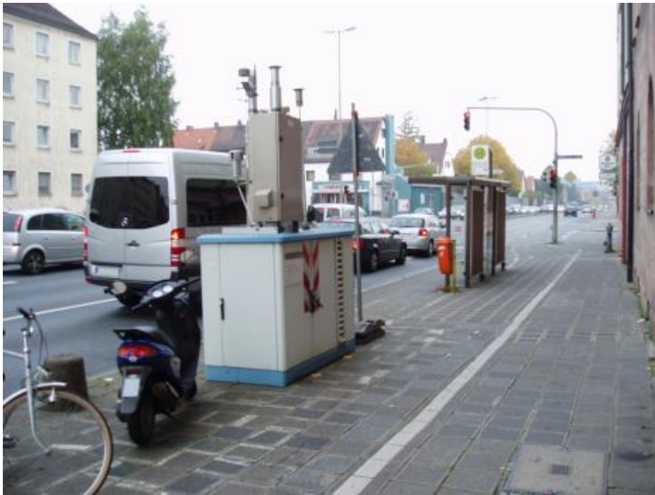
Abb. 25: Stationsansicht Blickrichtung Nord
