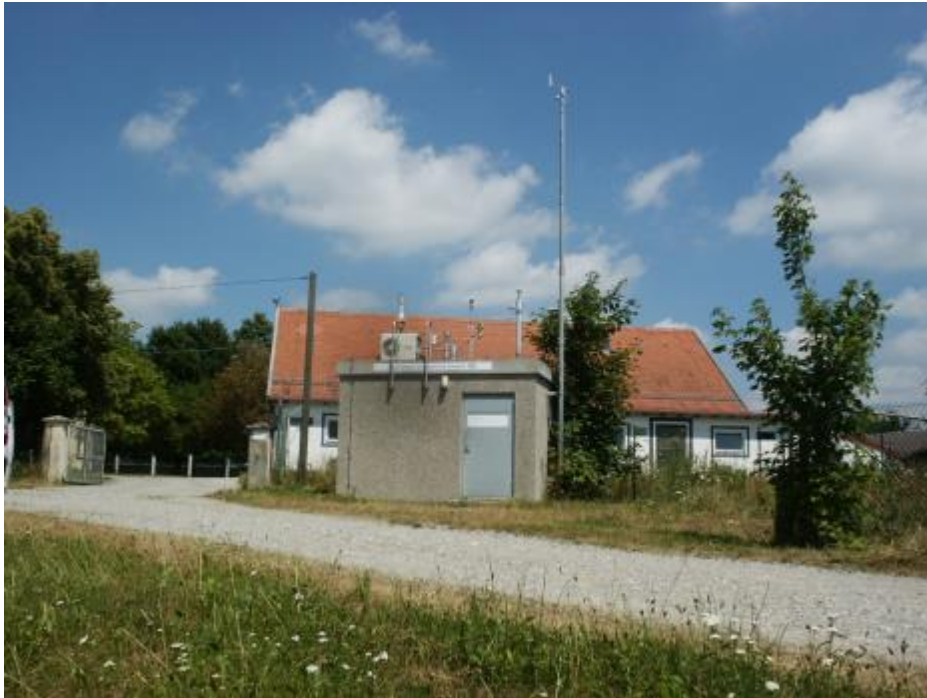
Abb. 1: Stationsansicht Blickrichtung Nord
