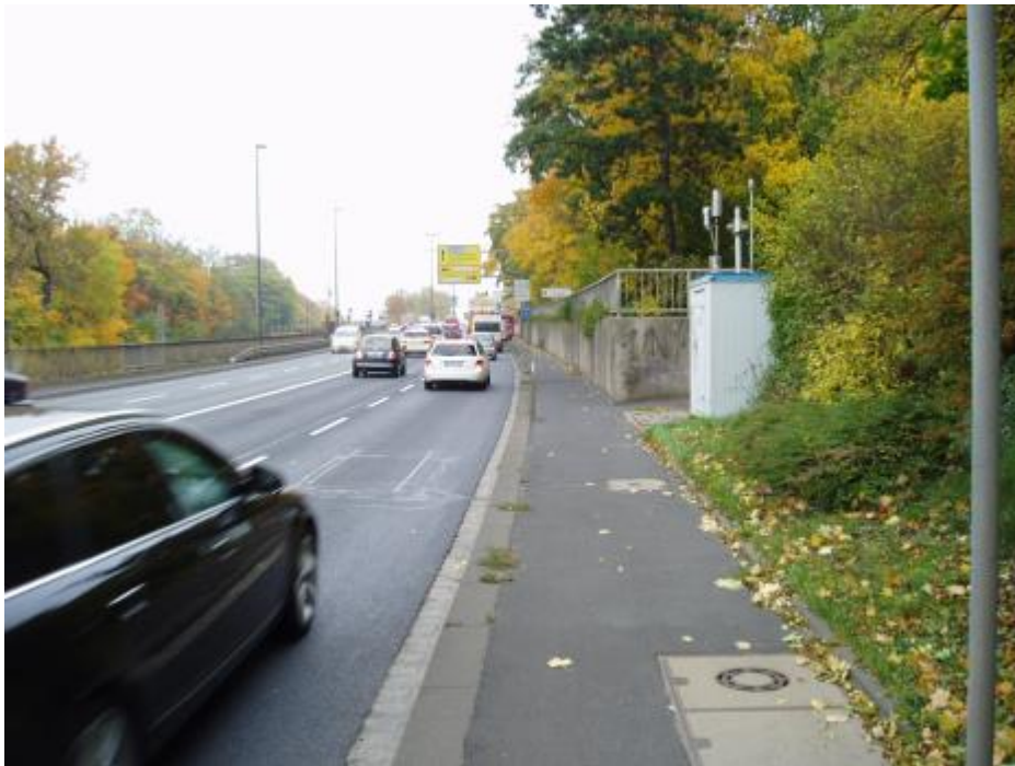
Abb. 37: Stationsansicht Blickrichtung Nord-Ost
