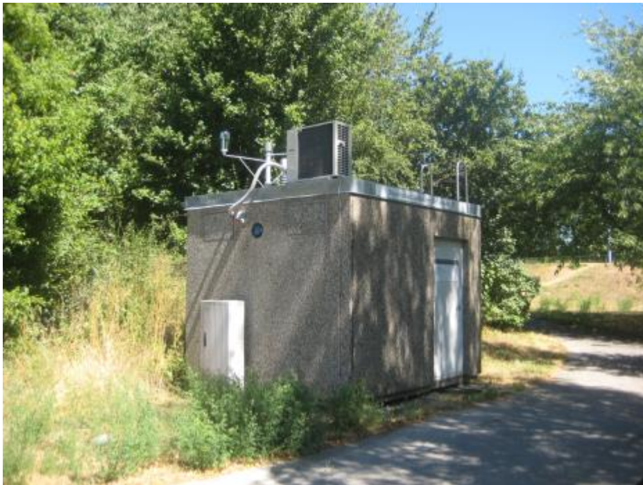
Abb. 11: Stationsansicht Blickrichtung Nord-Ost
