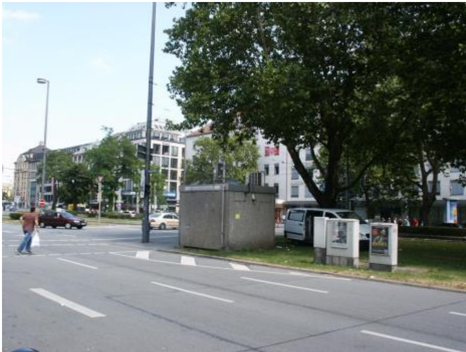
Abb. 23: Stationsansicht Blickrichtung Nord-Ost
