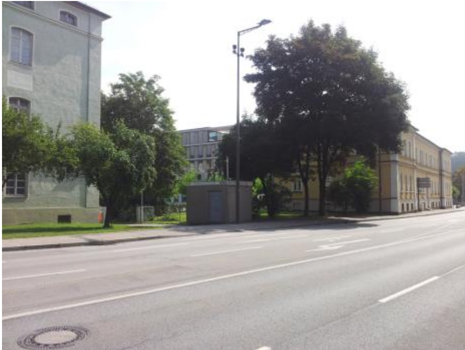
Abb. 17: Stationsansicht Blickrichtung Ost
