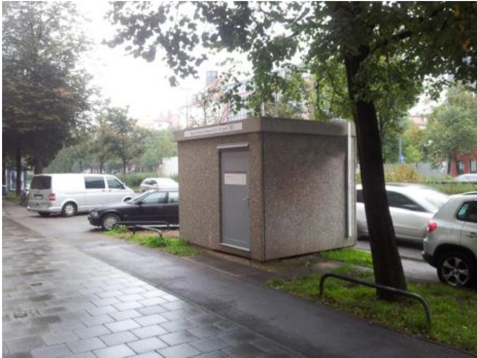
Abb. 21: Stationsansicht Blickrichtung Nord-Ost
