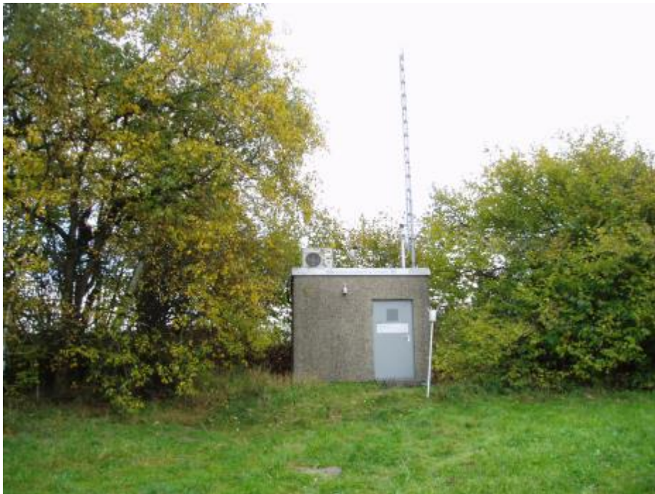
Abb. 33: Stationsansicht Blickrichtung Ost
