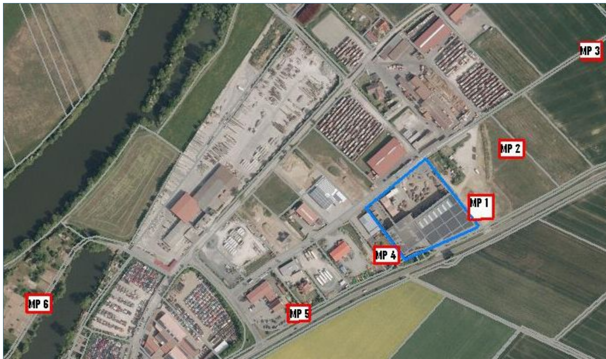
Abb. 11: Räumliche Lage der Messpunkte um die Elektroschrott- und Kabel-Aufbereitungsanlage in Nordbayern zur Messung der atmosphärischen Gesamtdeposition von PBDD/PBDF, PBDE, PCDD/PCDF und PCB sowie von Schwermetallen seit Anfang 2013. Die Grenzen des Werksgeländes sind blau markiert.
