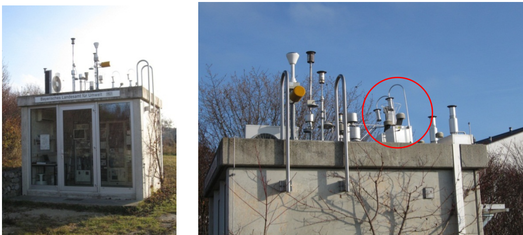
Abb. 11: Kleinfiltergeräte, Luftmesstation Augsburg Bürgermeister-Ulrich-Straße
