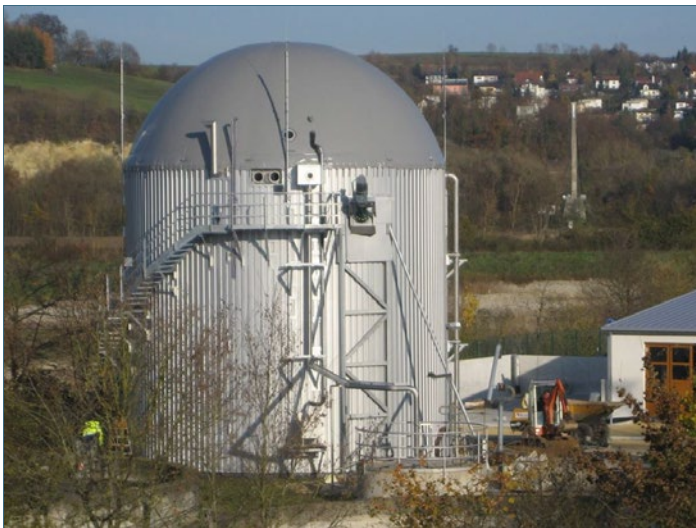
Abb. 4: Pilotprojekt „Energetische Optimierung durch Nachrüstung einer anaeroben Klärschlammbehandlung“ in Bad Abbach
