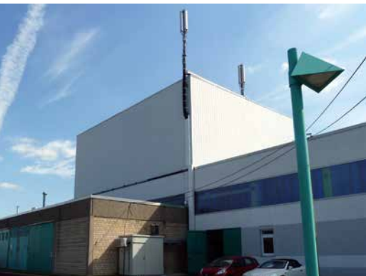
EMF-Ringversuch 2013: Ansicht der Mobilfunkbasisstation
