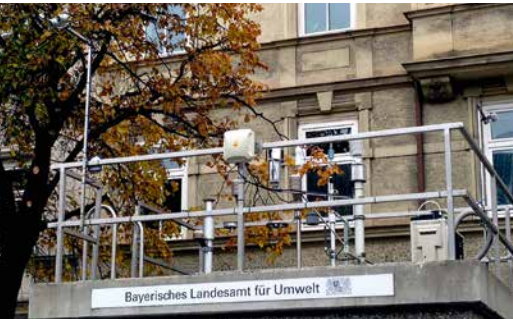
Die Landshuter Allee in München ist ein Messschwerpunkt des LfU. Die dortige Messstation erfasst auch die NO 2 -Konzentrationen in der Luft.
