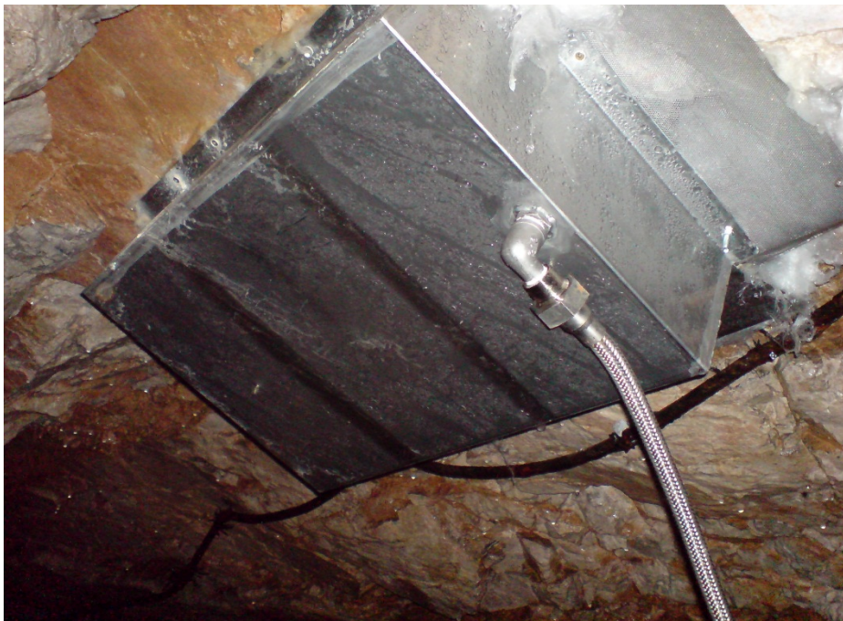
Abb. 2: Ausführung der luftdichten Fassung für die Quellwasserentnahme
