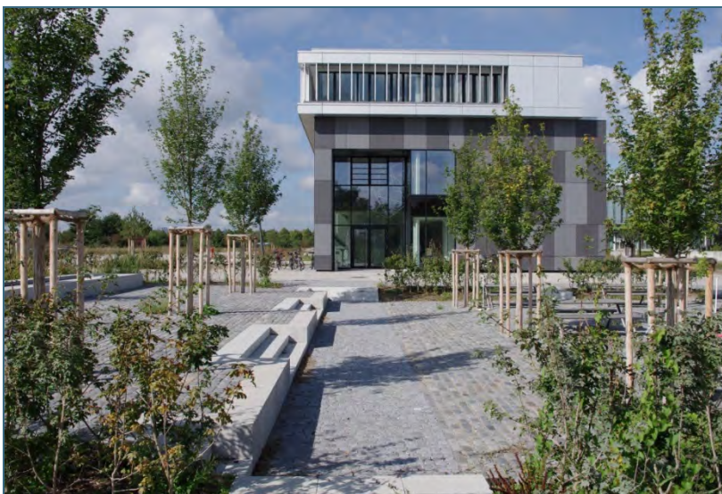
Abb. 4: Laborneubau mit Außenbereich Kantine
