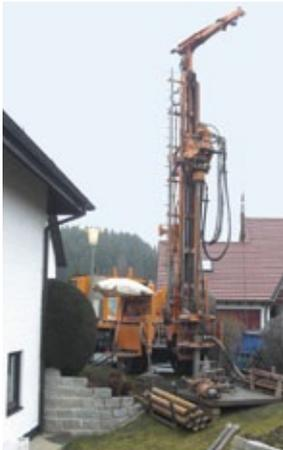
Mit Erdwärmesonden kann die regenerative oberflächennahe Geothermie insbesondere für Heizzwecke genutzt werden. Für die Errichtung ist meist eine wasserrechtliche Erlaubnis erforderlich. Private Sach-
