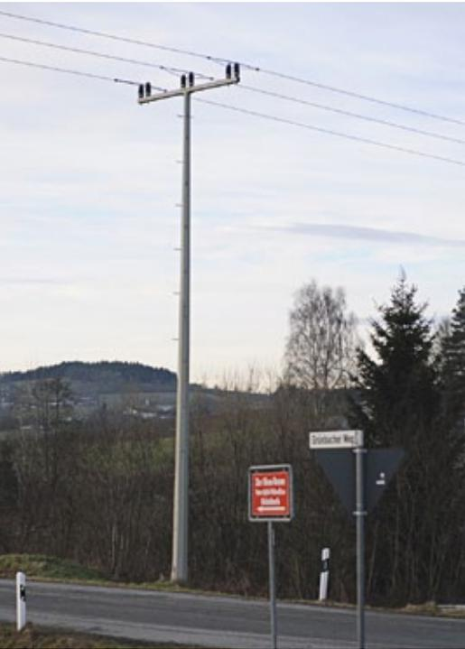
*Gefährlicher Mast einer Mittelspannungsleitung in Brutplatznähe eines Uhus: Mindestens einer der beiden mittleren Stützisolatoren muss mit einer Abdeckhaube gesichert werden, in Verbindung mit einer wirksamen Isolierung der Leiterseile.*
