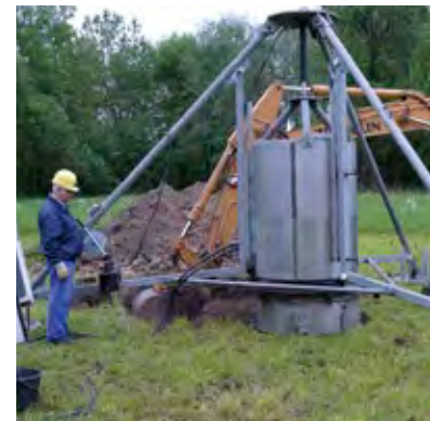
Mit speziellen Bohrgeräten können Bodensäulen unterschiedlicher Größe entnommen werden.
