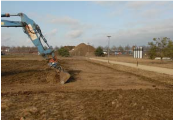
Abb. 2: Vorbereitung des LfU-Neubaus
